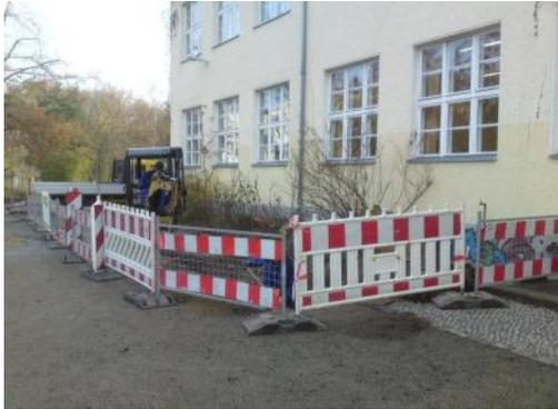
Im Zusammenhang mit dem Bau der Turnhalle im gelben Schulleitung wurde im Dezember eine Gasleitung zum Hauptgebäude verlegt. Dort soll ein Blockheizkraftwerk dann sowohl das Gebäude als auch die Turnhalle mit Wärme und Strom versorgen.
