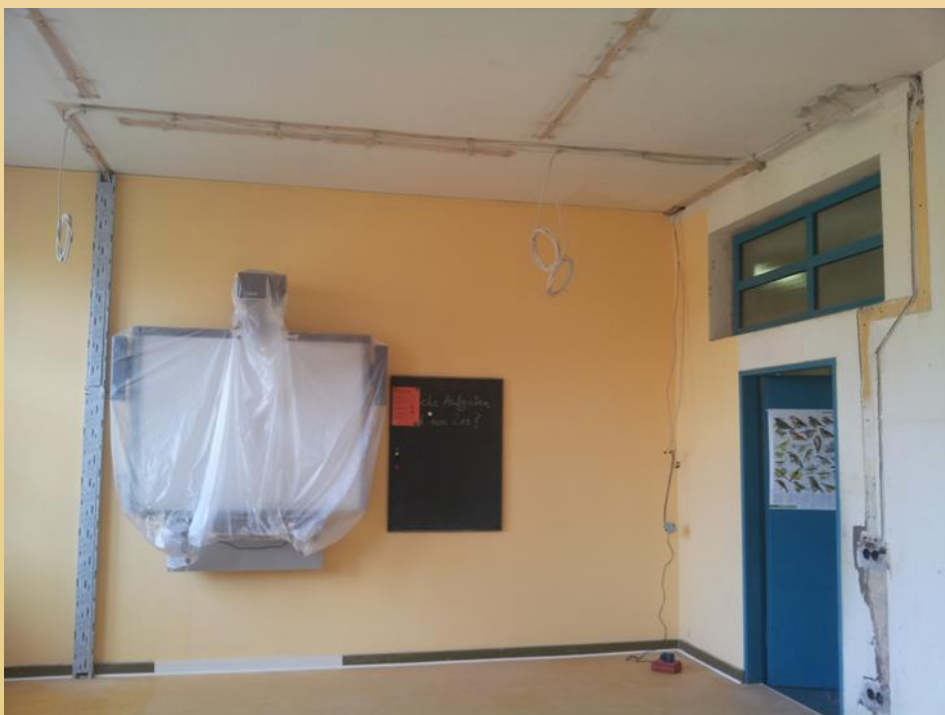
Erneuerung der Elektroleitungen
