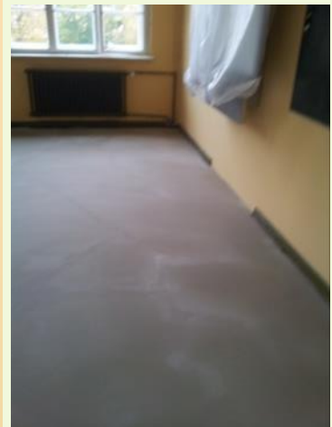
Erneuerung des Fußbodens
